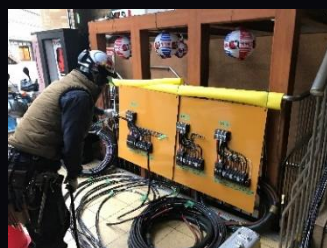
●仮設分電盤設置工事
