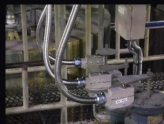
●リミットスイッチ交換工事
