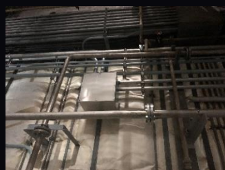
●電気設備据付工事
