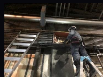
●回路切替工事
