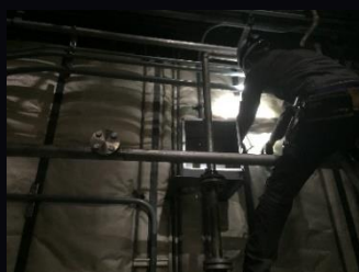
●電気設備据付工事
