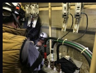
●トランス組立、ヒューズ交換工事
