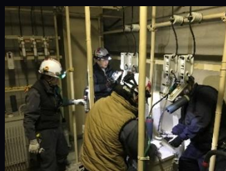
●キュービクル工事
